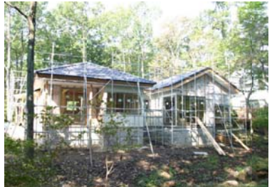
外壁工事が進むE-55
